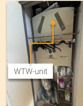
Ventilatie warmteterugwinning
